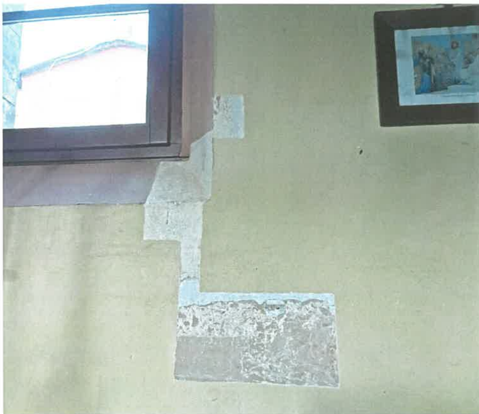
Fot. 9. Ściana północna. Wykonanie odkrywek na ścianie oraz na glifie okiennym.
