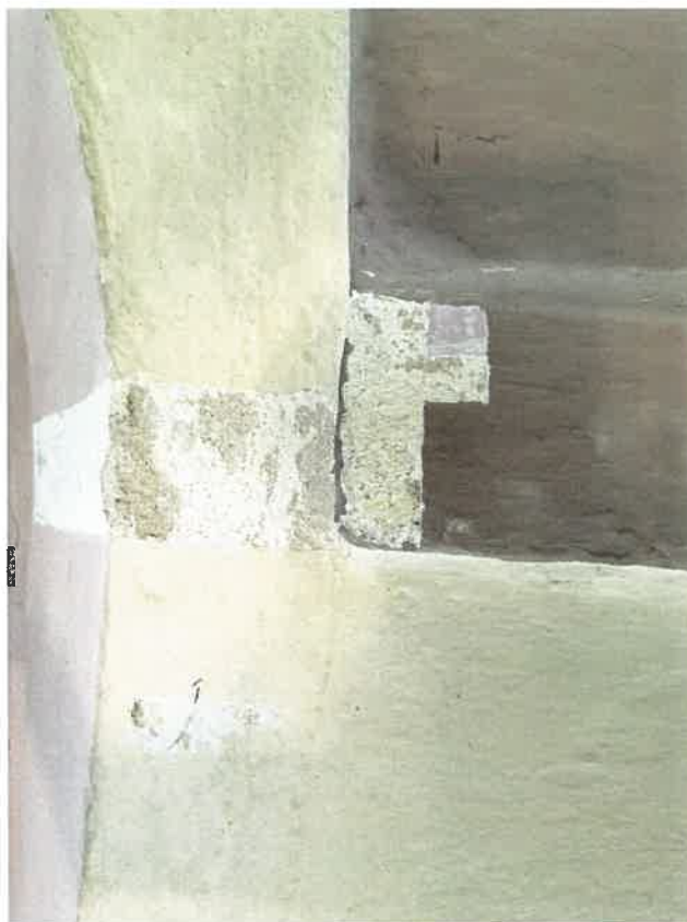
Fot. 17. Ściana północna. Odkrywki wykonane na wsporniku, w glifie okiennym i na ścianie.
