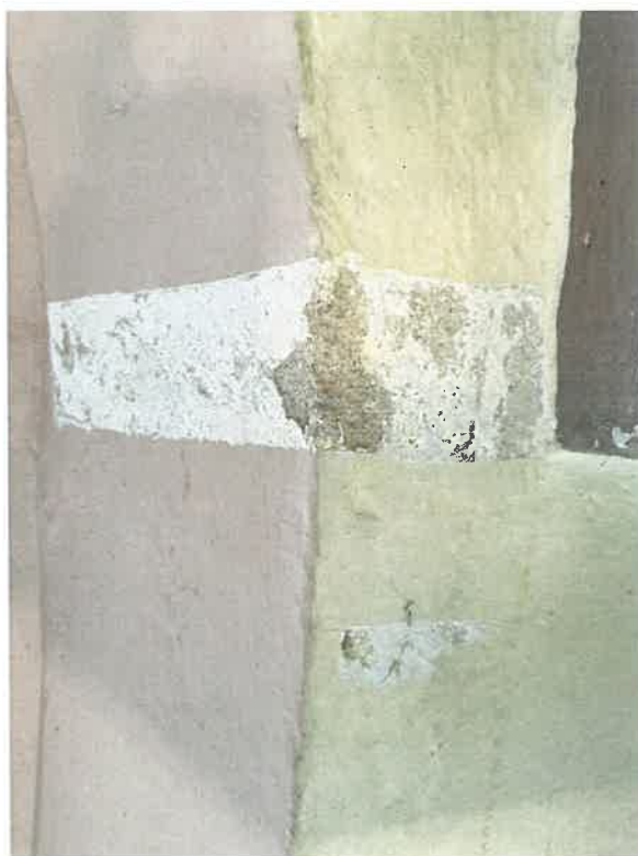
Fot. 18. Ściana północna. Odkrywki wykonane na wsporniku, w glifie okiennym i na ścianie.
