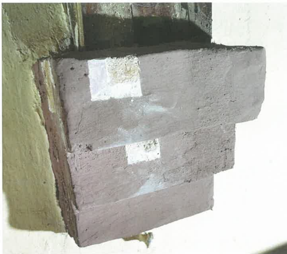
Fot. 15. Wspornik na ścianie wschodniej. Odkrywka schodkowa.
