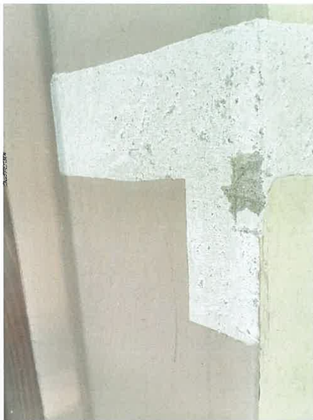
Fot. 11. Ściana północna. Odkrywka w glifie okiennym ukazująca pierwotną jasnokremową warstwę malarską.
