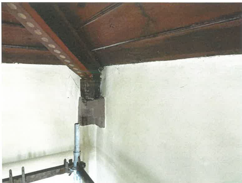
Fot. 2. Wnętrze kościoła, ściana wschodnia i północna. Obecna kolorystyka ścian.
