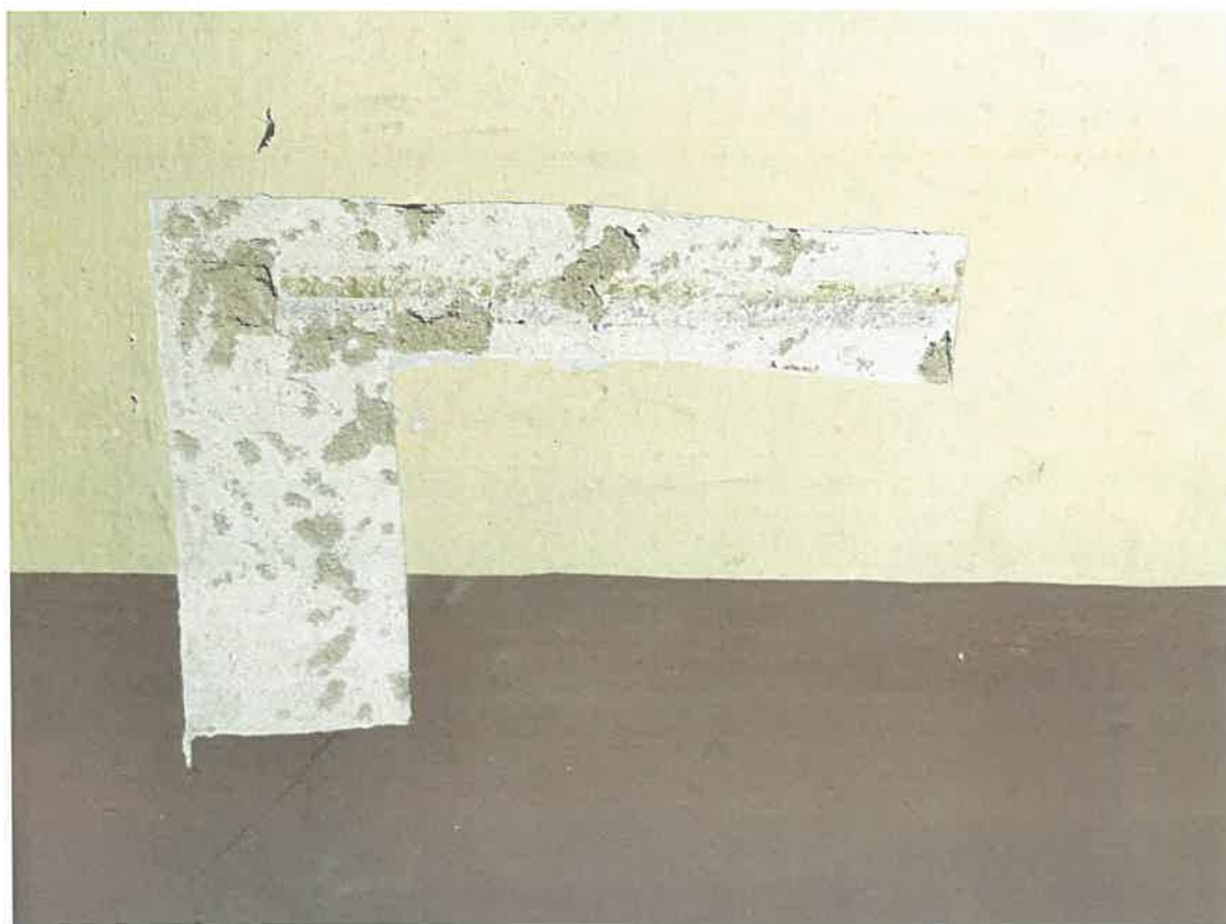
Fot. 24. Ściana zachodnia na emporze muzycznej. Odkrywka ukazująca dwa pasy, brązowy i czarny o szerokości 2 cm.
