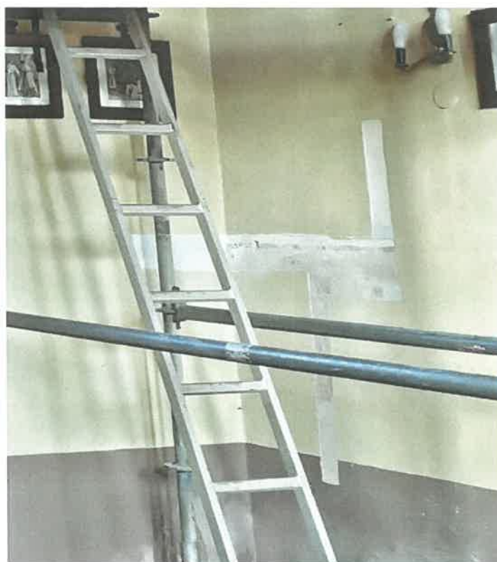
Fot. 12. Ściana wschodnia i północna. Odkrywka ukazująca jasnobrązową warstwę malarską na wysokości 165 cm, zakończoną ciemnym paskiem.
