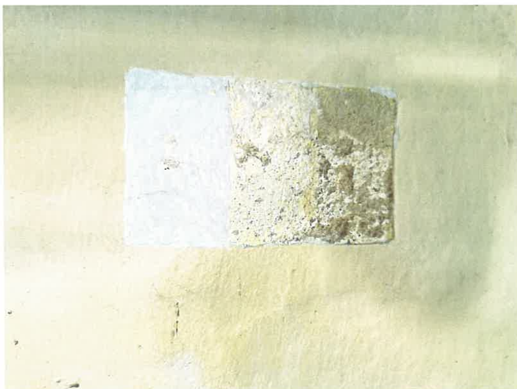
Fot. 14. Ściana północna. Odkrywka schodkowa. Widoczna jasnokremowa oryginalna warstwa malarska.
