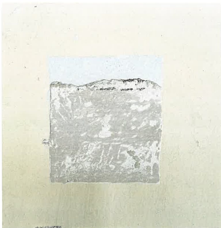
Fot. 8. Ściana północna. Odkrywka ukazująca jasnobrązową warstwę malarską wraz z ciemnym paskiem. Widoczna także wtórna zaprawa powyżej.
