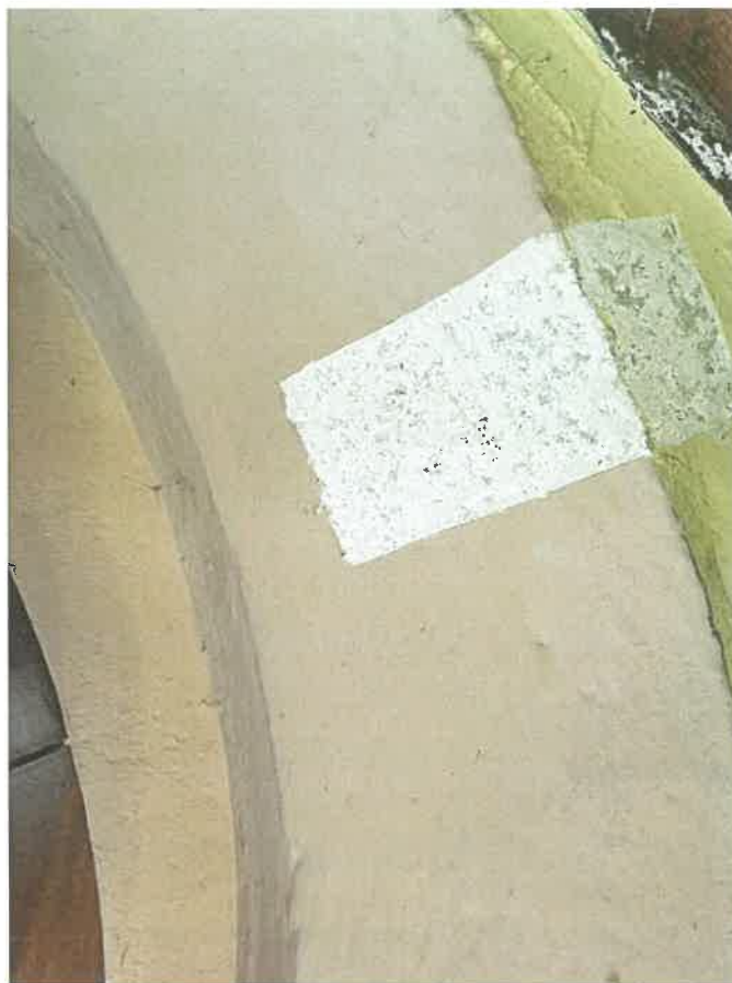
Fot. 19. Ściana północna. Odkrywki wykonane na wsporniku, w glifie okiennym i na ścianie.
