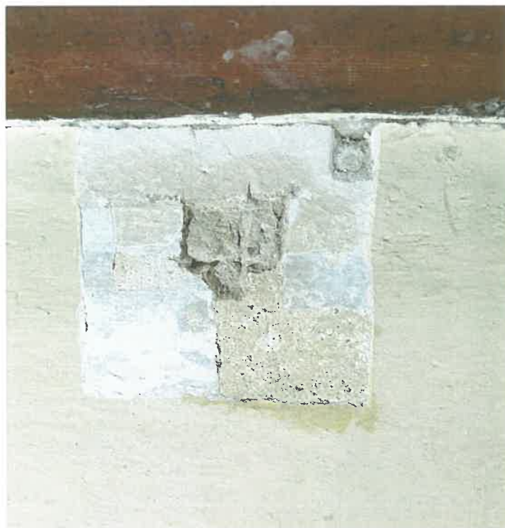
Fot. 13. Ściana wschodnia. Wykonanie odkrywki schodkowej. Widoczna jasnokremowa warstwa oryginalna, zachowana fragmentarycznie.
