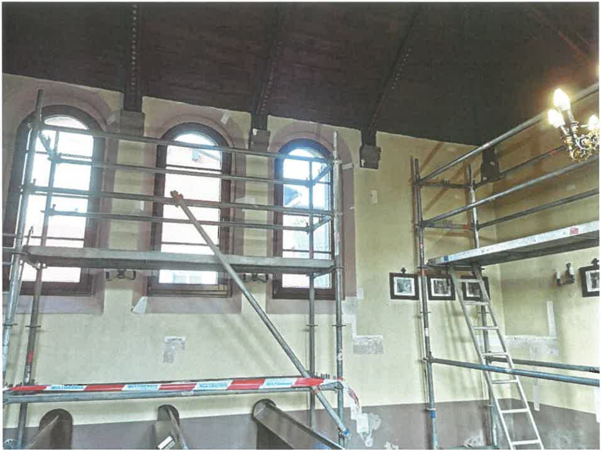
Fot. 27. Wnętrze kościoła. Stan po wykonaniu odkrywek.
