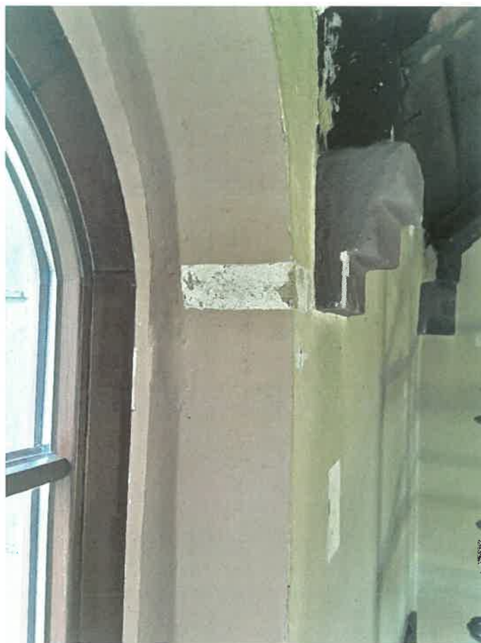
Fot. 21. Ściana południowa. Odkrywka schodkowa na ścianie.
