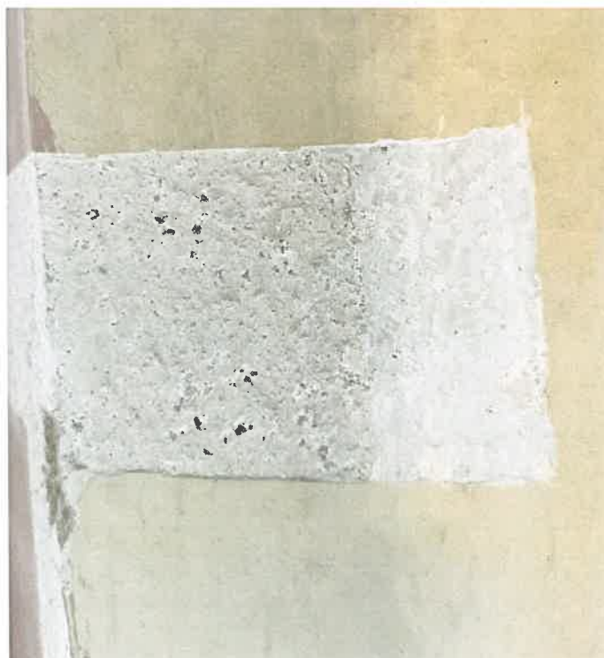
Fot.20. Ściana południowa. Odkrywka schodkowa na ścianie.
