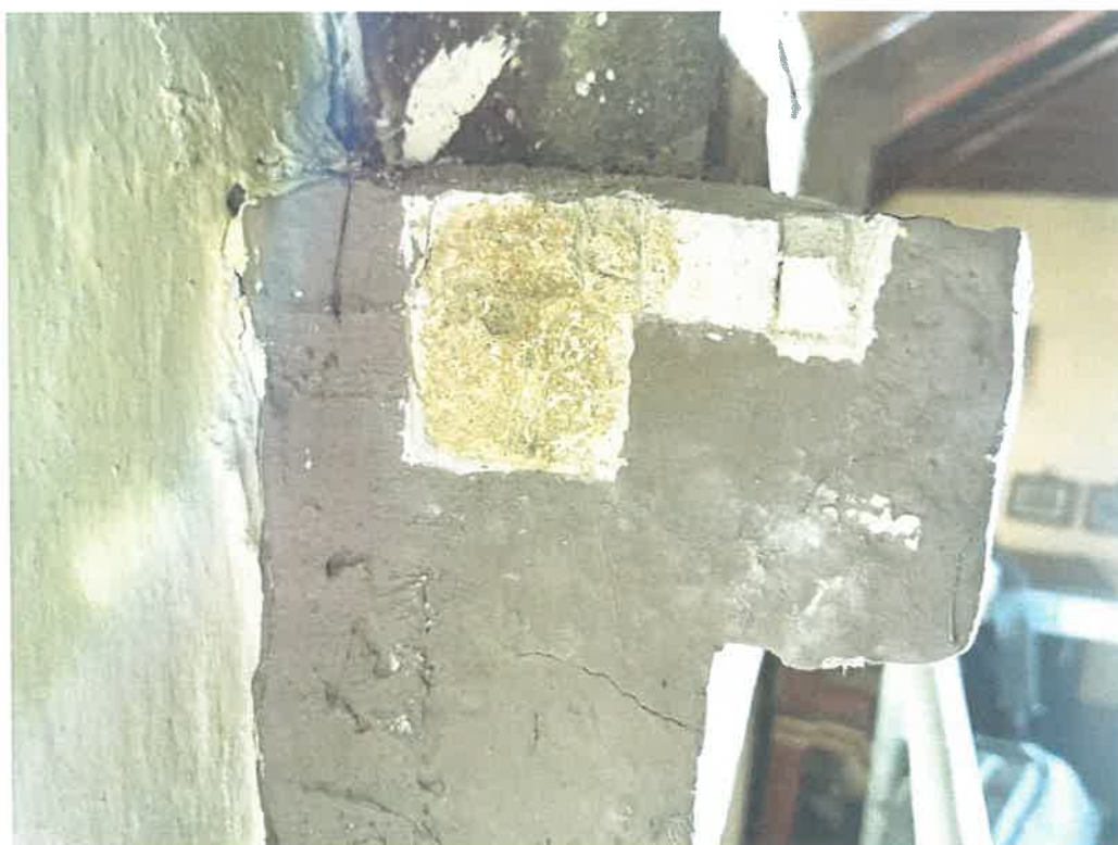
Fot. 16. Wspornik na ścianie wschodniej. Odkrywka schodkowa.
