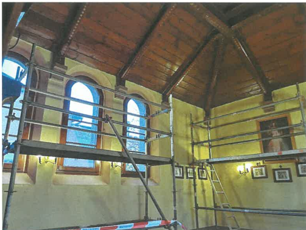
Fot. 1. Wnętrze kościoła. Obecna kolorystyka ścian.
