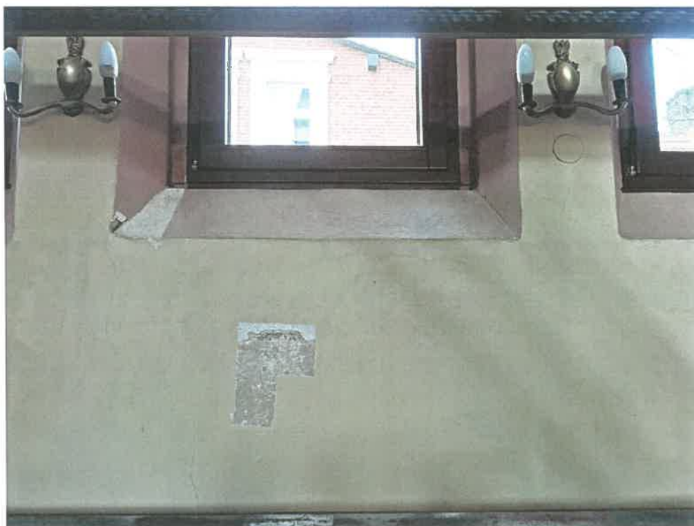
Fot. 4. Ściana północna. Odkrywka w gładzie okiennym oraz na ścianie. Widoczny jasny, wtórny tynk powyżej jasnobrązowej odkrytej warstwy malarskiej.
