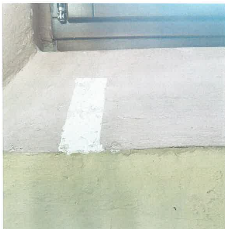
Fot. 22. Ściana południowa. Odkrywka w glifie okiennym.
