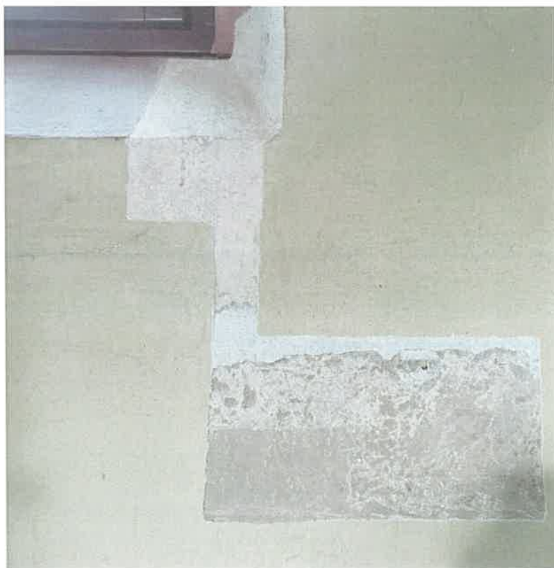
Fot. 10. Ściana północna. Wykonanie odkrywek na ścianie oraz na glifie okiennym.
